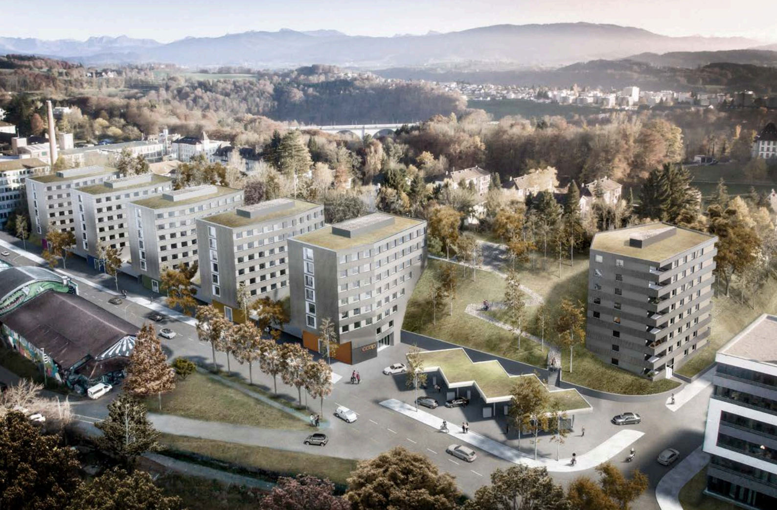
Vue aérienne des 5 immeubles Apartis, en bas de l'image la station-service avec magasin et le bâtiment d'habitation.
