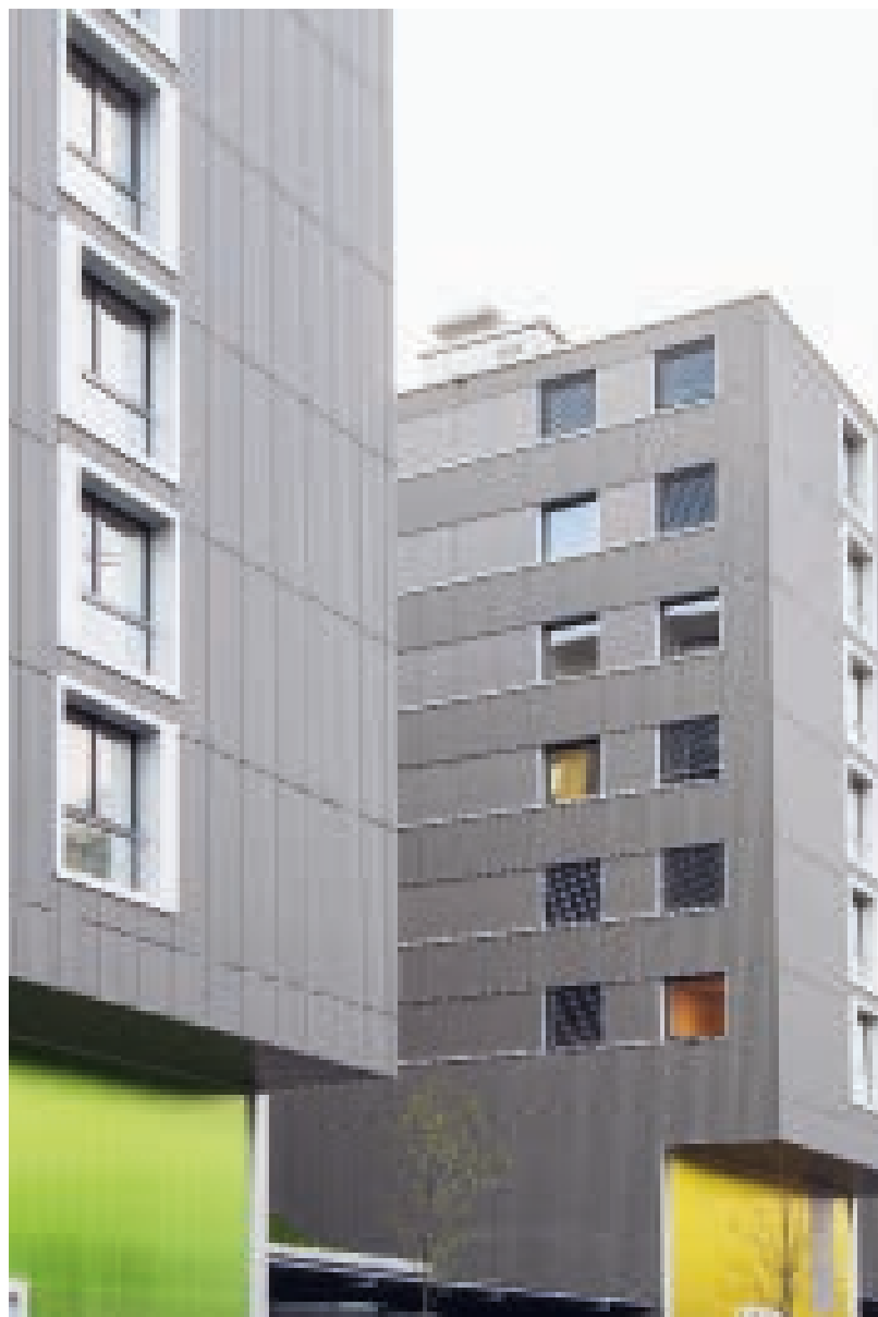
Les façades des immeubles depuis la rue de la Fonderie.
